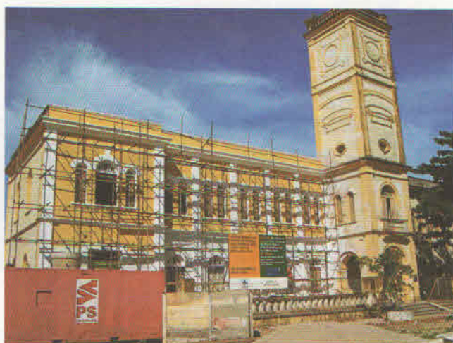
Fachada em obras da antiga Estação Sampaio Correia
