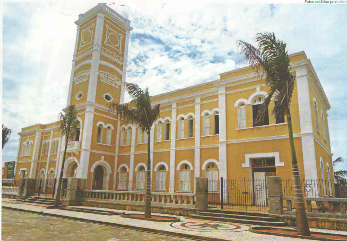
Fachada restaurada da antiga Estação Sampaio Correia
