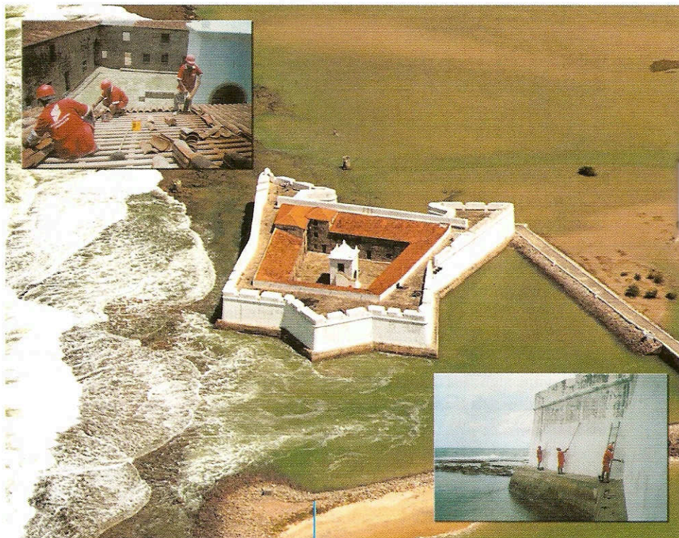
Recuperação da Fortaleza dos Reis Magos em 2005
