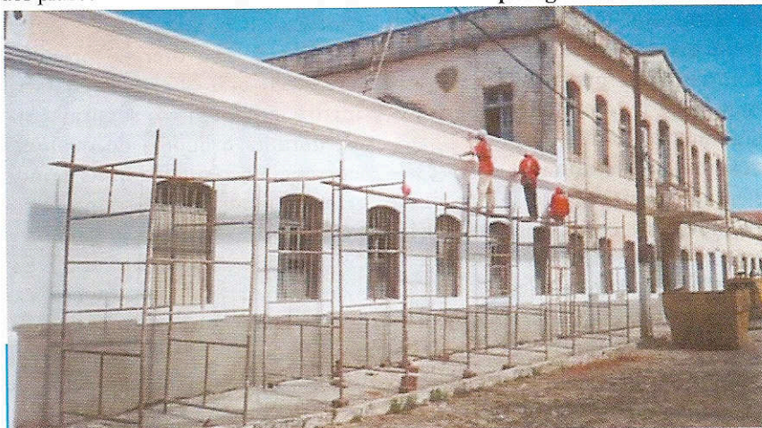
Casa do Estudante durante recuperação executada pela P.S. Engenharia
