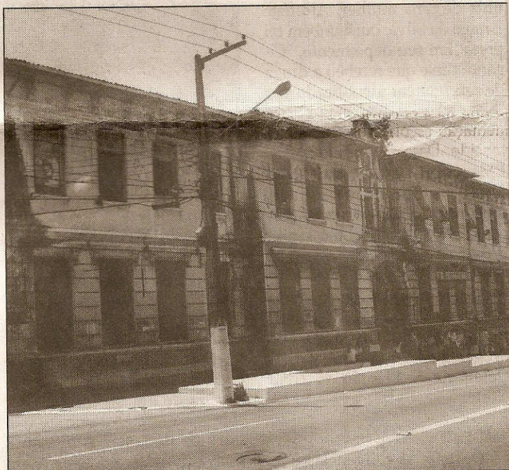
O prédio será desocupado para o início das obras até o dia 26
